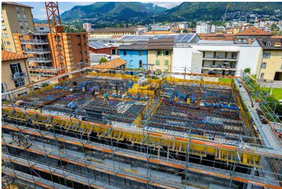
Errichtung der 4. Decke.
