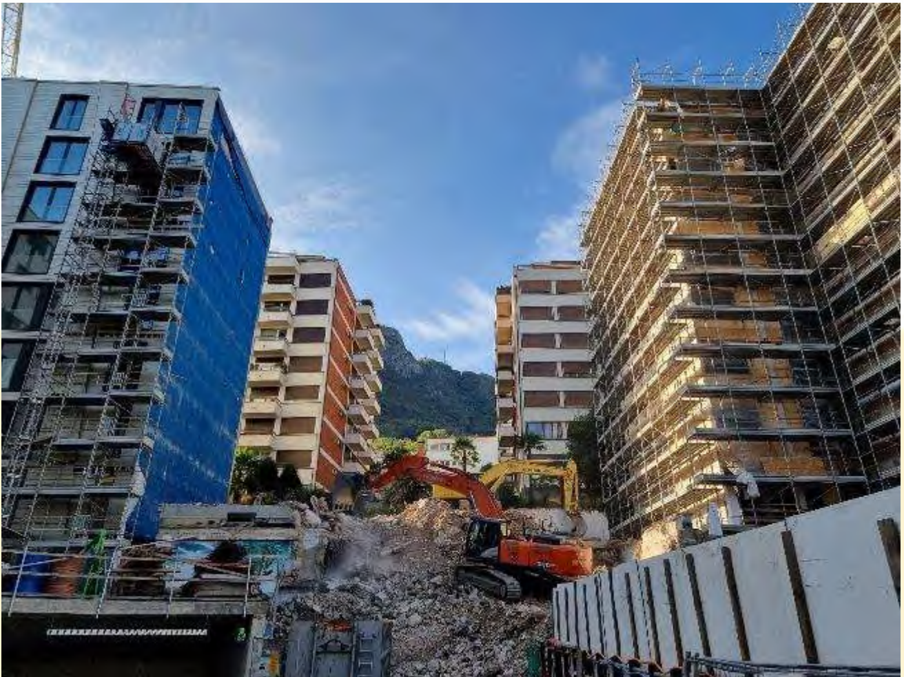
Abbruch des bestehenden Gebäudes: das dritte Wohngebäude wird zwischen den beiden errichtet.
