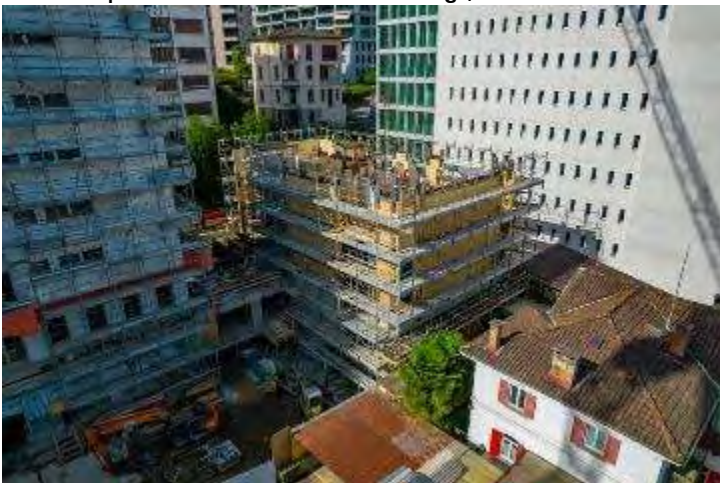
Drohnenaufnahme des Gebäudes
